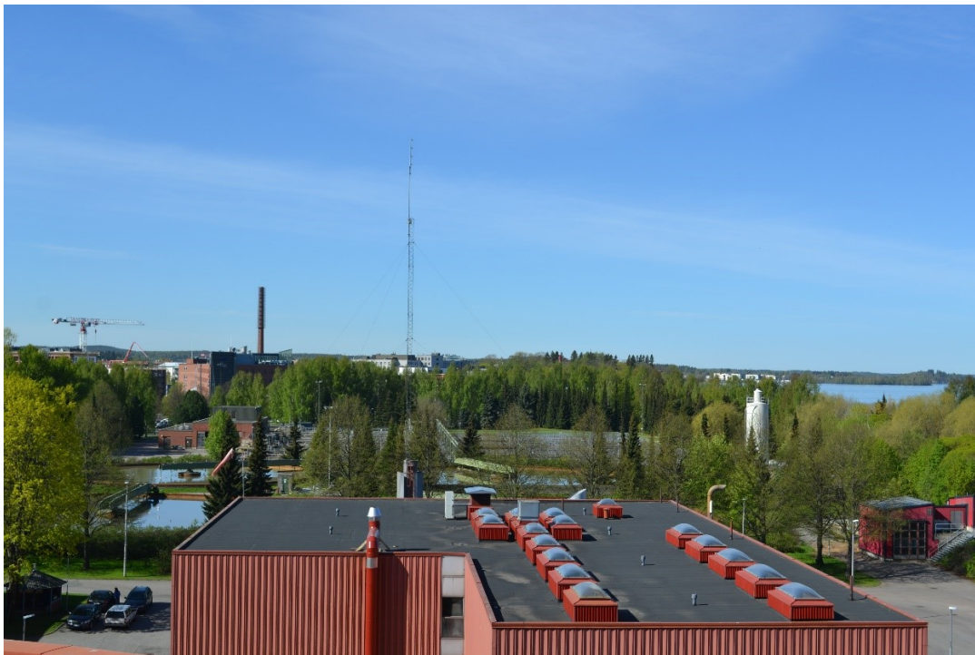
Näkymä mädättämön katolta kohti lietteenkäsittelylaitosta. Puhdistamon ensimmäiseen rakennusvaiheeseen kuuluva laitos sijaitsee alueen ytimessä.
