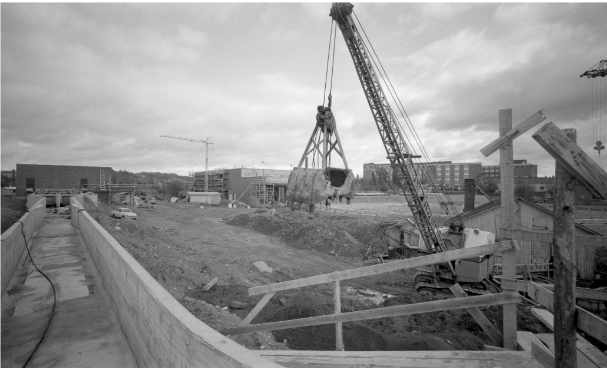
Jätevedenpuhdistamon rakennustyöt. KUVA Timo Palm 7.10.1971/Vapriikin ka.
