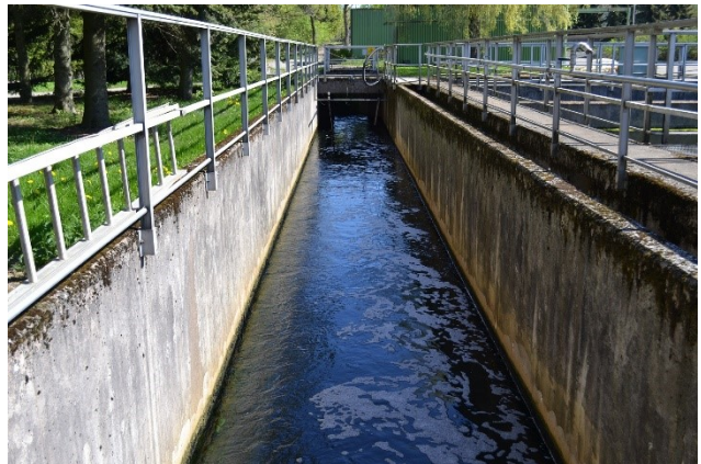
Näkymä lännestä ilmastus- ja jälkiselkeytyksaltaille, uusin laajennusosa (vas.). Jälkiselkeytyksen poistokanava, josta puhdistettu vesi johdetaan Pyhäjärveen (oik.).
