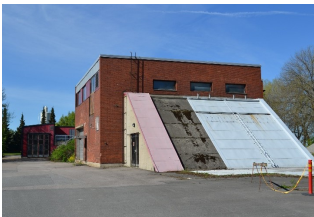
Vino katto kattaa pumppaamon nousuputket.
