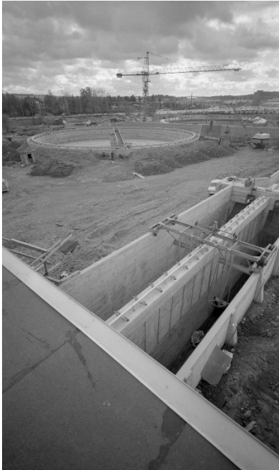
Hiekanerottamo, välppäämö ja lietealtaan reuna rakenteilla. KUVAT Timo Palm 7.10.1971/Vapriikin ka.
