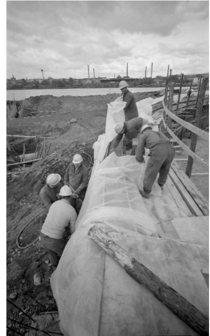
Hiekanerottamo, välppäämö ja lietealtaan reuna rakenteilla. KUVAT Timo Palm 7.10.1971/Vapriikin ka.
