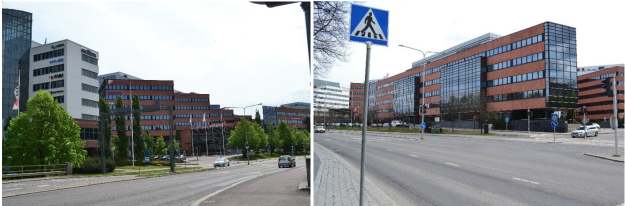
Toimistorakennus pohjoisen ja etelän suunnasta Hatanpään valtatieä.
