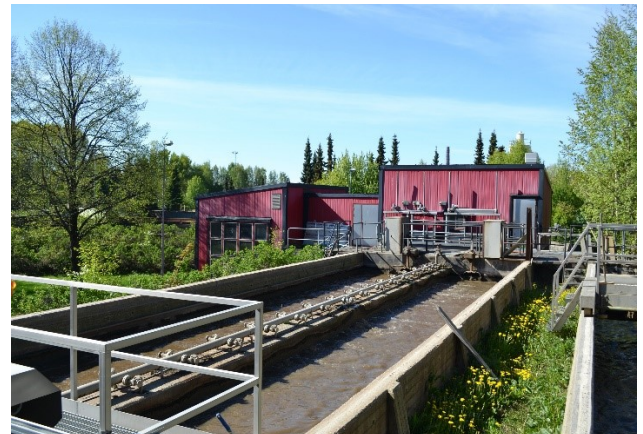
Hiekanerottamo ja sen takana hienovälppäämö.
