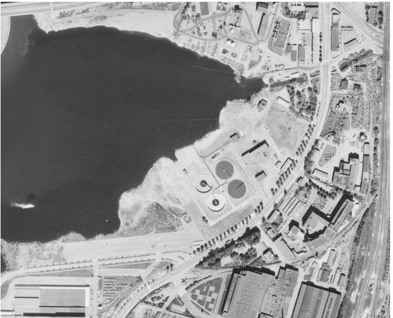
Jätevedenpuhdistamon ensivaiheen rakennukset valmiina vuonna 1974. KUVA Tampereen kaupunki.
