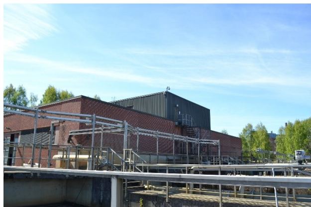
Näkymä ilmastusaltailta. Julkisivua hallitsee korkea tuuletustila.
