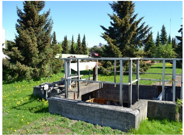
Altaiden ympärille on istutettu kuusikkoa ja pensaita. Kalkin ja ferrisulfaatin syöttöasema esiselkeytyksen ja ilmastusaltaiden välissä.
