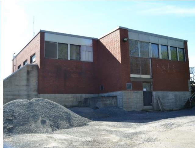
Takajulkisivu Pyhäjärven suuntaan pohjoiseen.
